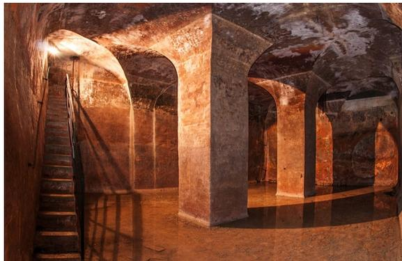
**Figura 22** - Vano "a" della cisterna con i due pilastri. Si nota il colore marrone rosso sul pavimento e sui muri fino a circa 5 metri di altezza.
