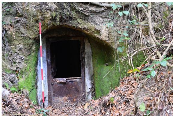
**Figura 16** - Ingresso di un cunicolo drenante della sorgente Trinità in sinistra del torrente tributario di sinistra del Fosso della Botte. L'asta è lunga 1,5 m.
